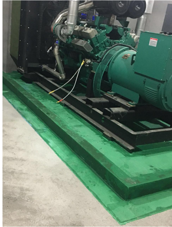
发电机基础防渗（防止污染地下水）
